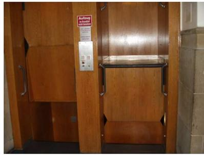
Abbildung 42: Ein Paternoster kombiniert gewisse Vorteile einer Rolltreppe mit denen eines Aufzugs.
