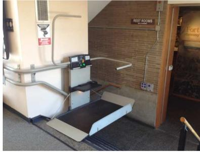
Abbildung 44: Ein Schrägaufzug ist eine mit einer Treppe kompatible Weiterentwicklung eines Aufzugs. Schrägaufzüge gibt es, so wie hier dargestellt, als kompakte Systeme. Auf U-Bahnhöfen gibt es aber auch große Schrägaufzüge mit einer Kabine.
