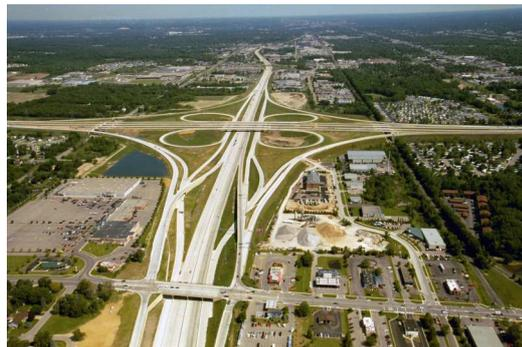
Abbildung 23: Eine Kreuzung von zwei Straßen führt zu widersprüchlichen Wünschen der Autofahrer auf den beiden Straßen. Eine Brücke ist eine Separation dieser widersprüchlichen Anforderungen im Ort.
