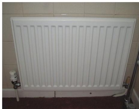
Abbildung 49: Ein Heizkörper stellt die Funktion „erwärmt Luft“ zur Verfügung. Soll der Heizkörper getrimmt werden, so muss diese Funktion auf eine andere Komponente übertragen werden.
