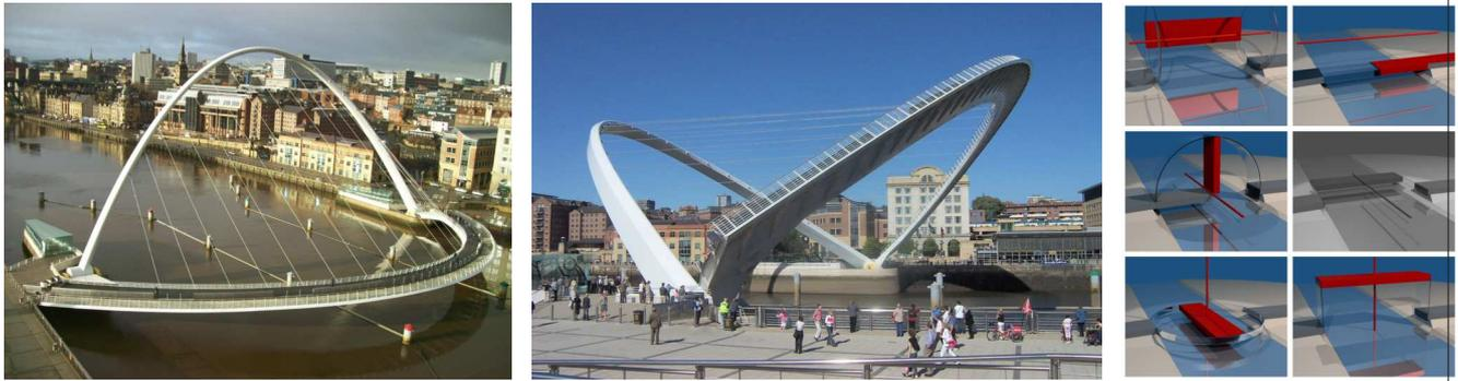
Abbildung 26: Kippbrücken schaffen nur temporär eine räumliche Ressource, die von einem Schiff genutzt werden kann. Rechts sind die fünf verschiedenen Optionen dargestellt, mittels denen eine Neuordnung in der Richtung bzw. im Ort den notwendigen Raum schaffen kann.
